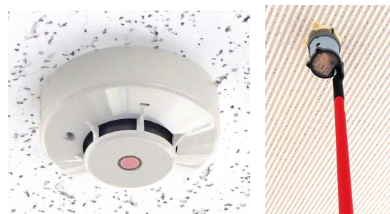
図1 煙感知器と作動試験装置
