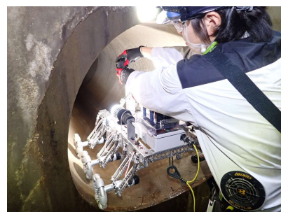
図1 孔内探査車を使用した点検作業
