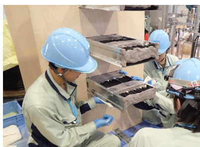
図6 施工性確認試験
