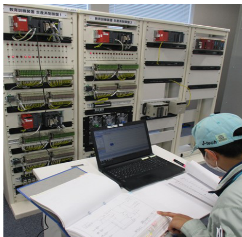
図4 保守・保全員による保守・保全作業訓練の様子
